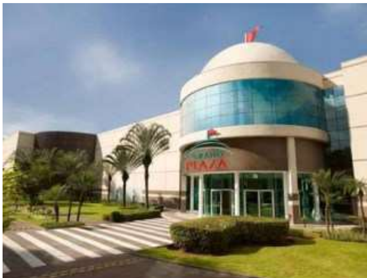
Figura 22 - ABCP11 Foto do ativo que compõe o fundo
